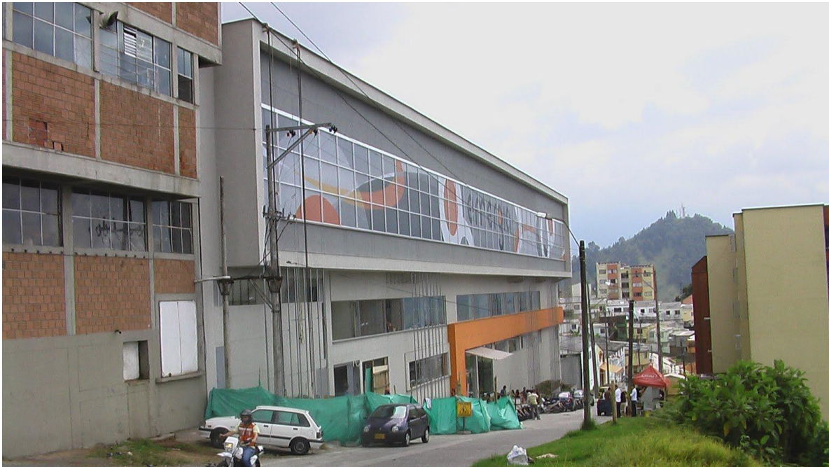
Aspecto de la remodelación de la fachada principal de la nueva empresa Call Center Emergia. Estas instalaciones pertenecían a la fábrica de plásticos Riduco, quien se relocizó en la zona industrial de La Enea, al extremo oriental de la ciudad de Manizales. Foto Acebedo.
