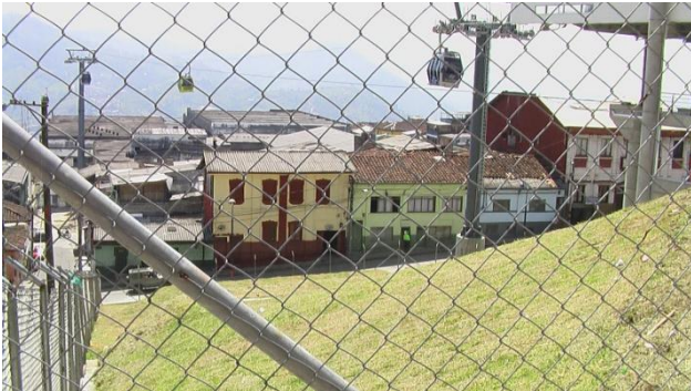
Tratamiento de exteriores de la estación del cable aéreo del centro de Manizales. Foto Acebedo.
