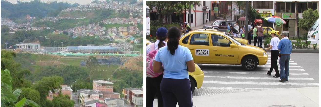
A la derecha, panorámica de la Terminal de Transportes intermunicipal en el sector de Los Cámbulos, Manizales, Caldas. A la izquierda, la ausencia de un puente peatonal pone en riesgo permanente la seguridad de los ciudadanos. Fuente: Archivo propio.
